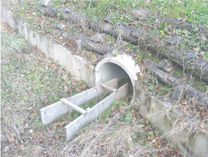
Figure 13.—Un déflecteur (ici en bois) mis en place à l'entrée de chaque passage (des deux côtés de la route) dès 2006 et permettant de maximiser le taux de pénétration des batraciens dans les passages inférieurs.
